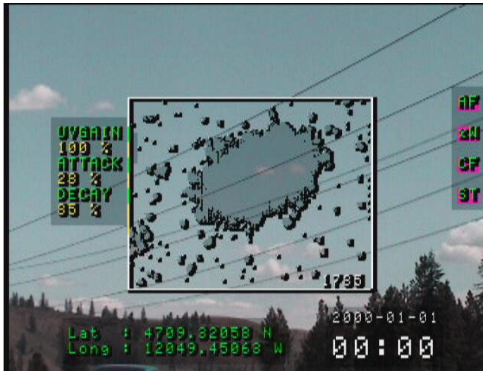
Slika 8.15. Prikaz korone između vodiča pomoću „Korona kamere“
