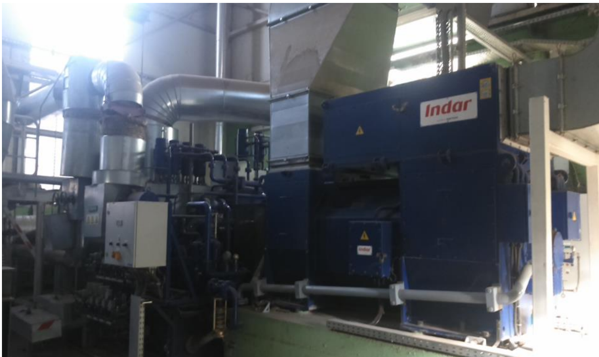
Slika 5.15. Turbo-generatorski set
