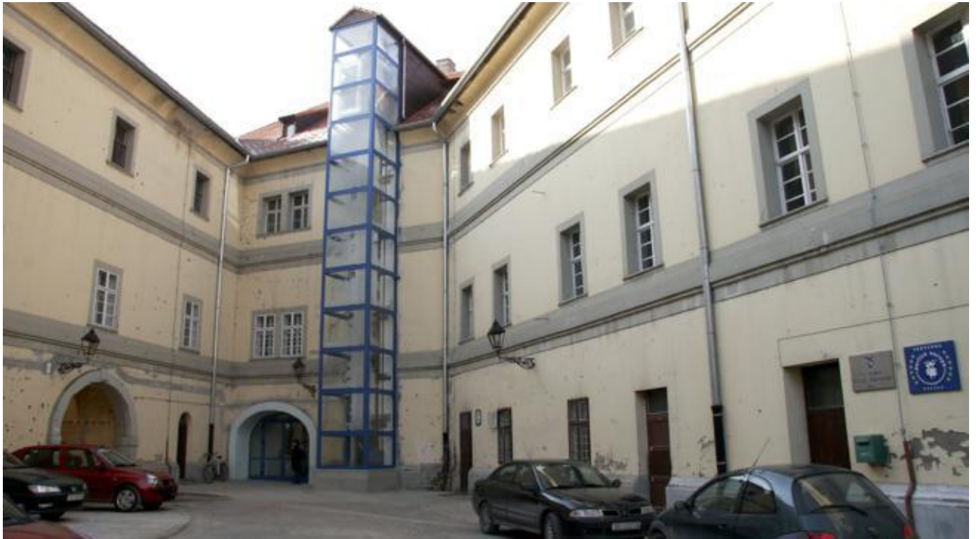
Fotografija 2. Zgrada škole
