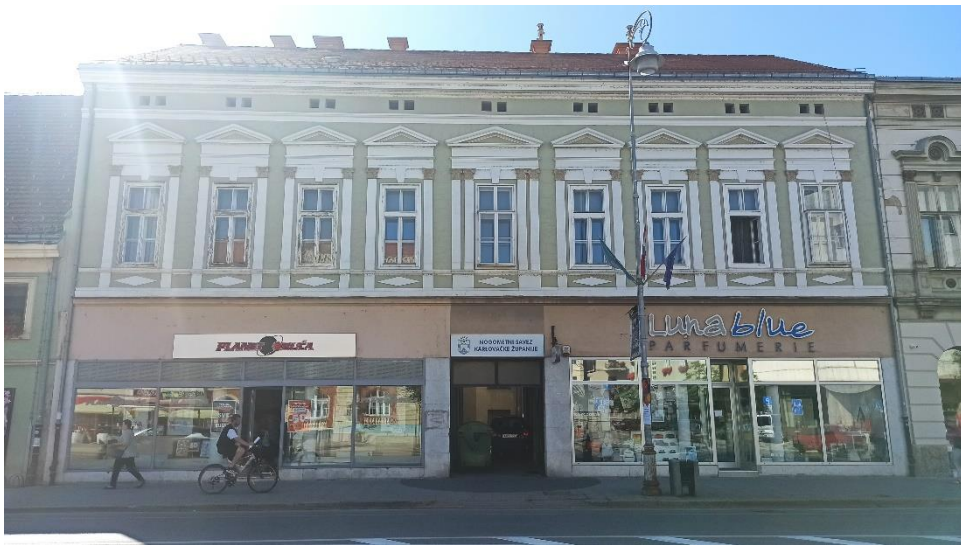
Kuća Banjanin na Zrinskom trgu 5, 1880ih (1. 7. 2022.)
