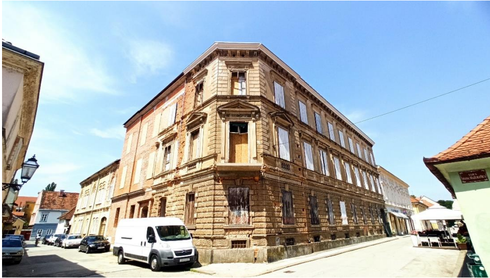
Zgrada Srpske pravoslavne općine u Radićevoj ulici 14, 1882. (29. 6. 2022.)
