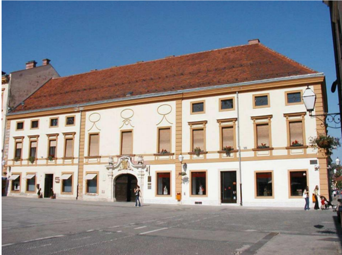
Slika 18. Glavno pročelje palače Drašković
