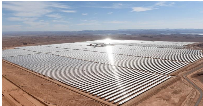
Sl.3.9. Solarna termoelektrana s paraboličnim žljebastim kolektorima u Maroku kod Oaurzazate-a [16]
