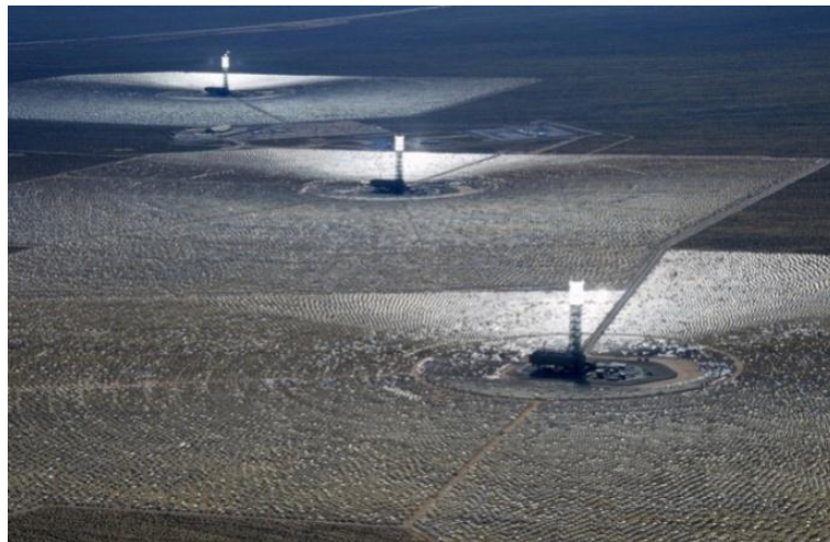
Sl.3.14. solarna termoelektrana Ivanpah s tri tornja s prihvatnikom i poljima heliostata [20]
