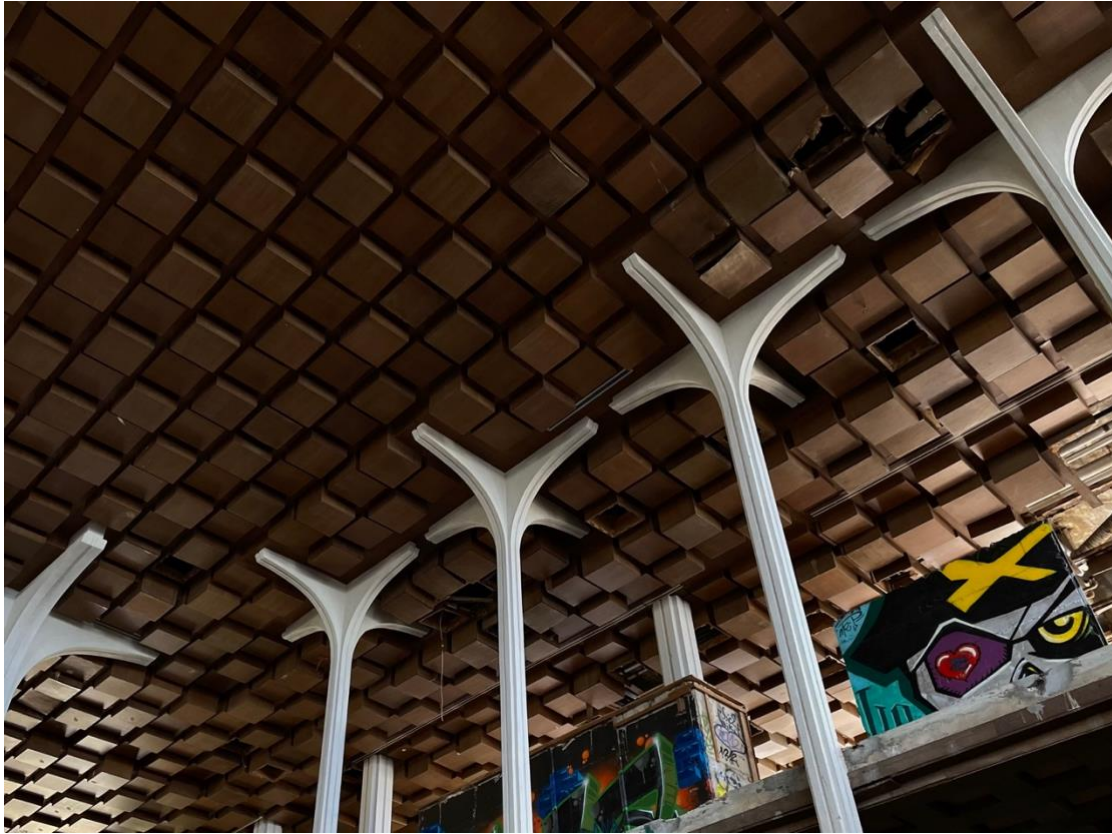
Sl. 13. Detalj stupova u središnjem prostoru
