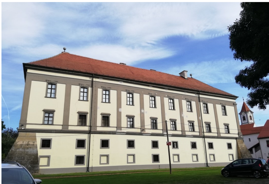
Slika 10: Jugoistočno pročelje, pogled s juga
