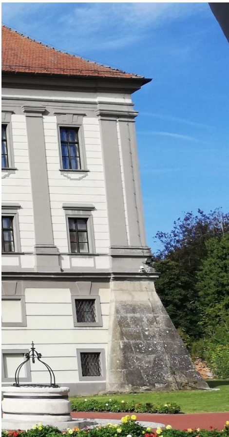
Slika 8a: Dvostruki pilastri iznad kontrafora
