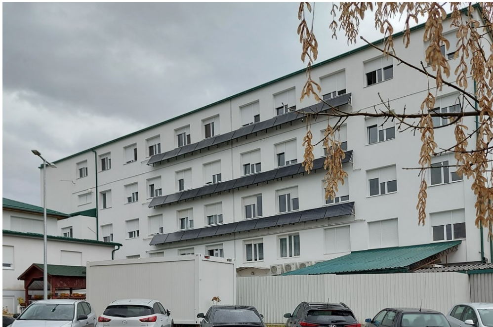
Slika 143. Pogled na zapadno krilo bolnice
