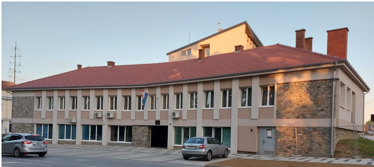
Slika 116. Glavno pročelje Policijske postaje - današnji izgled
