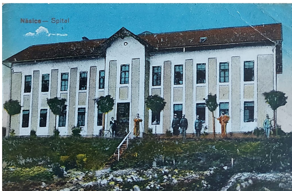
Slika 96. Glavno pročelje nekadašnje ubožnice (vojne bolnice)
