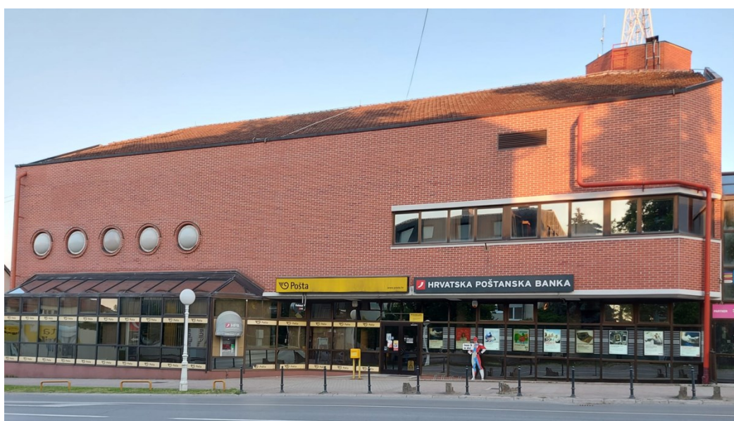
Slika 154. Nova pošta, glavno pročelje
