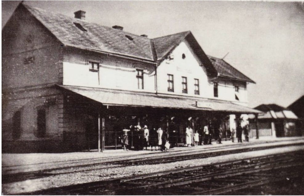
Slika 49. Stari željeznički kolodvor oko 1930.
