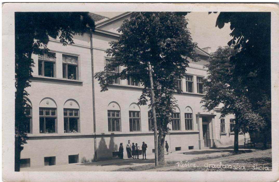
Slika 93. Glavno pročelje Građanske škole
