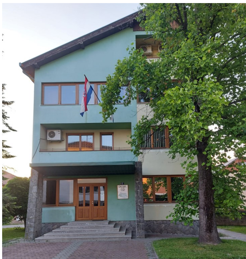
Slika 129. Glavno (južno) pročelje šumarije - današnji izgled
