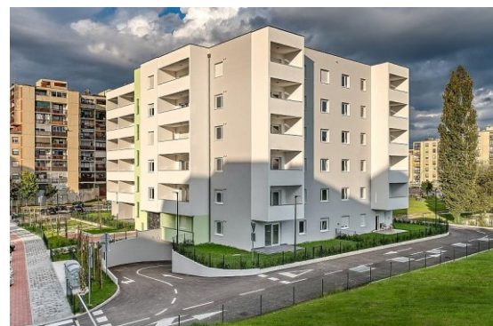
Slika 14. Stambena zgrada, gradska četvrt Grabrik, Karlovac
