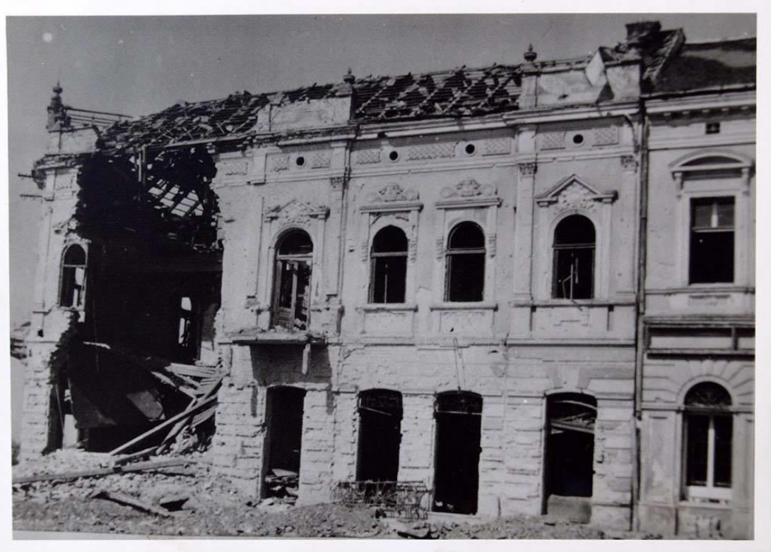
Slika 26. Kuća D' Elia, 1944.
