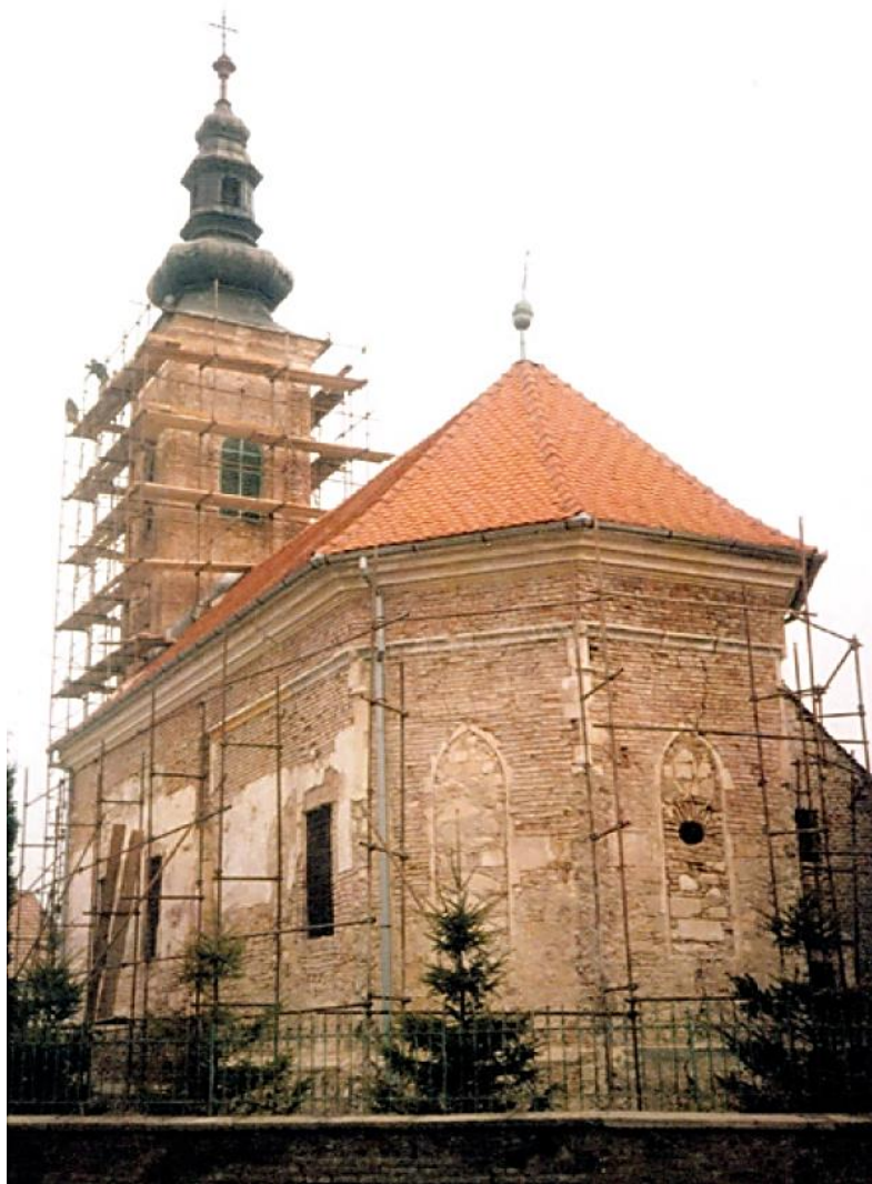
Slika 4 Crkva sv. Lovre, pogled na eksterijer svetišta i južni zid lađe, stanje nakon uklanjanja žbuke s vanjskih pročelja 1980-ih godina 324 (Marijana Korunek, Branka Marcuš, Josip Kovač, »Kapela i Trg sv. Lovre u Cirkovljanu«, u: Godišnjak Hrvatskog restauratorskog zavoda 6 (2015), str. 57)
