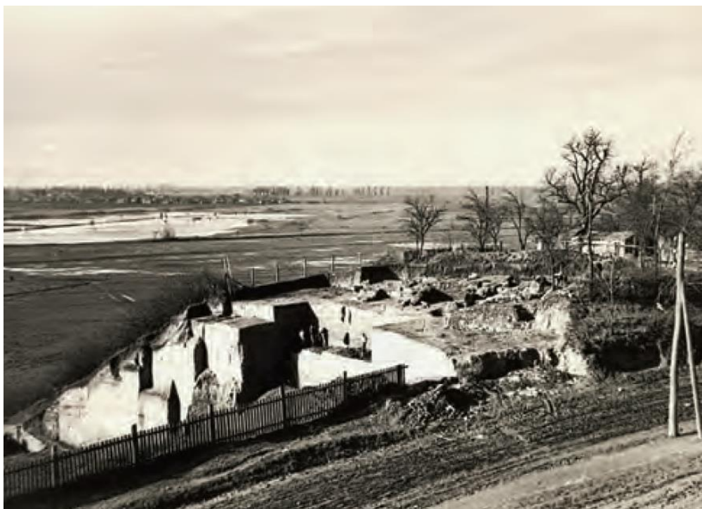
Slika 42 Otkop ciglane s otkrivenim temeljima crkve sv. Mihovila, pogled sa sjeveroistoka.
