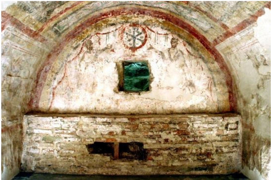
Sl. 21 – Sjeverni zid grobne komore sv. Petra i Pavla.
