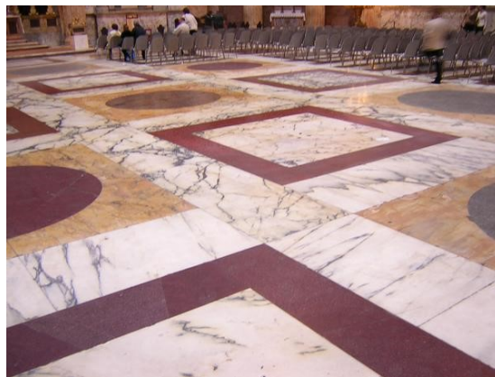
Slika 32 – Podno popločenje izvedeno od bijelog mramora, žutog numidijskog mramora ( giallo antico ), sivog granita i crvenog porfira iz Egipta, Panteon, Rim, 118. – 125. ( https://www.livius.org/pictures/italy/rome/rome-pantheon/pantheon-13-pavement/ , 25. 5. 2020.)
