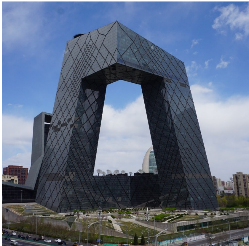
Slika 34. Sjedište CCTV-a nizozemskog arhitektonskog ureda OMA-e dovršeno u Bejingu 2012. godine
