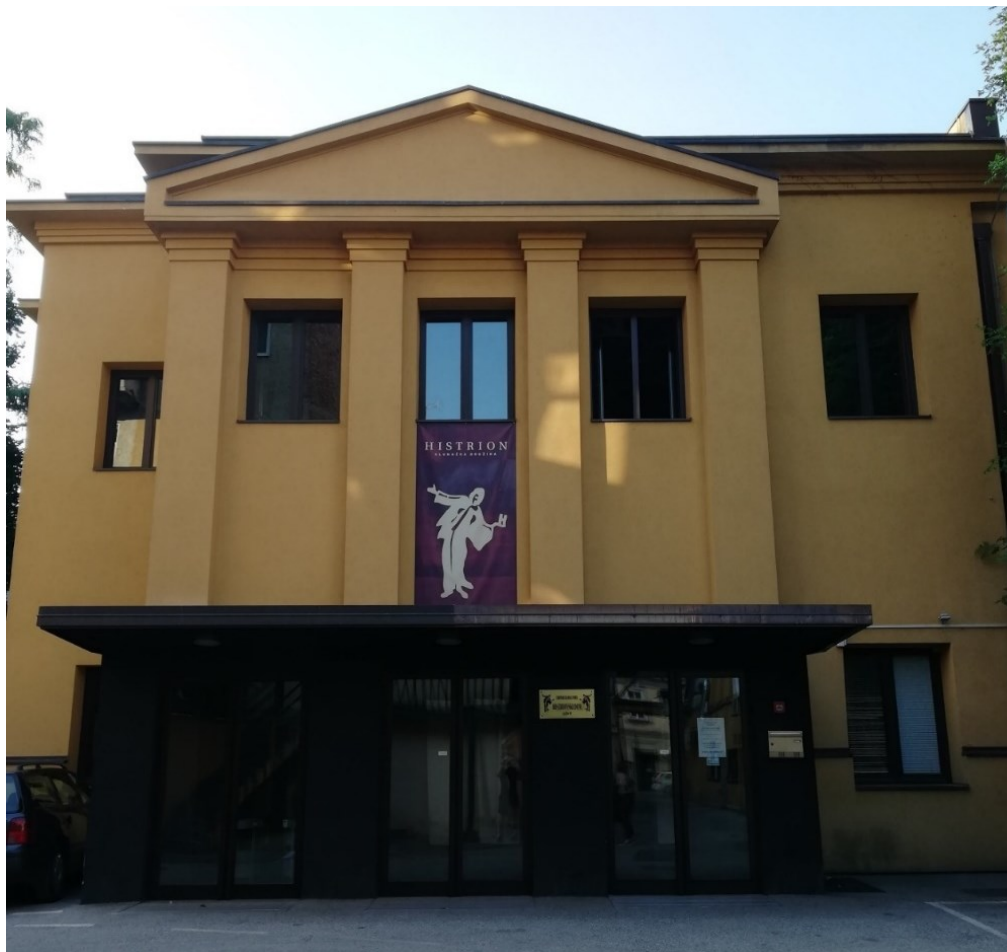
Slika 118. Prednje, južno pročelje Teatra Histrioni
