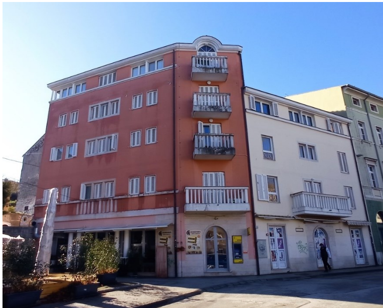
Slika 47. Pročelje zgrade na Kandlerovoj ulici
