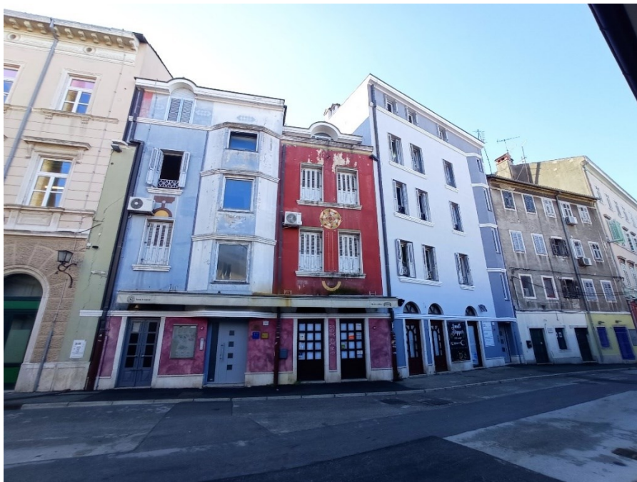
Slika 51. Pročelje zgrade na lokaciji br. 2
