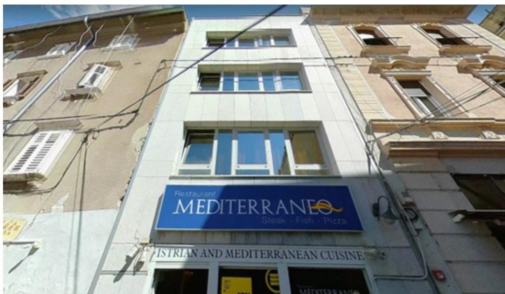
Slika 44. Pročelje poslovnog dijela zgrade
