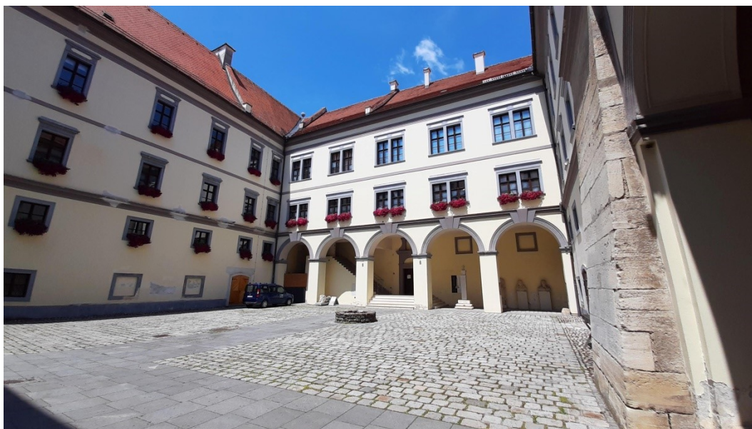
Slika 14: Dvorišna pročelja jugozapadnog i sjeverozapadnog krila, pogled s istoka
