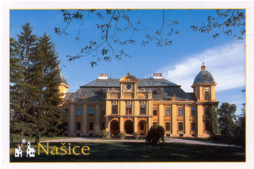
Slika 21. Dvorac obitelji Pejačević danas, južno (glavno) pročelje
