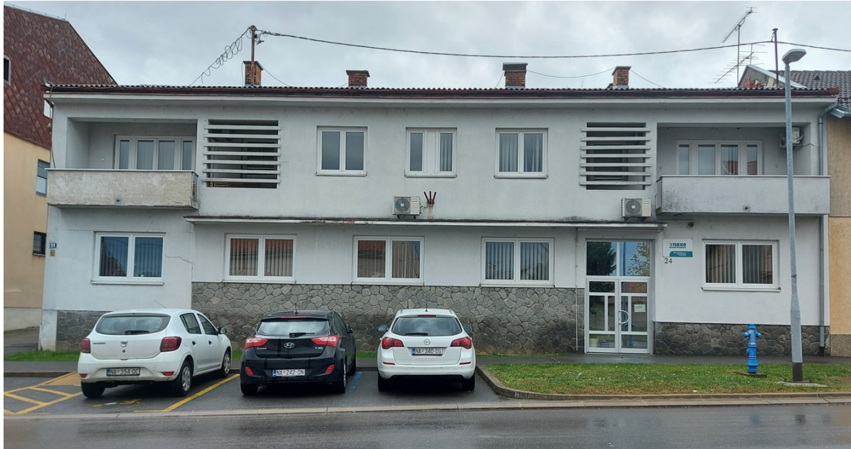
Slika 107. Glavno pročelje stambeno-poslovne zgrade u kojoj se danas nalazi sjedište tvrtke „Nexe gradnja“ d.o.o. Našice (nekada su se u njoj nalazile poslovne prostorije Građevnog poduzeća „Novogradnja“ Našice)
