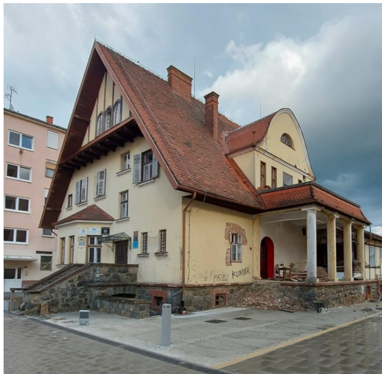
Slika 100. Pogled na sjeverno (glavno) i zapadno (bočno) pročelje
