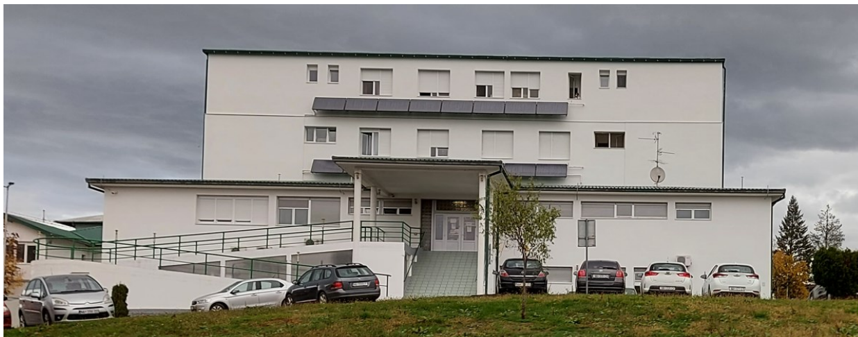
Slika 142. Južno pročelje bolnice
