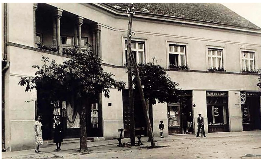
Slika 102. Glavno (sjeverno) pročelje kuće obitelji Hadžija
