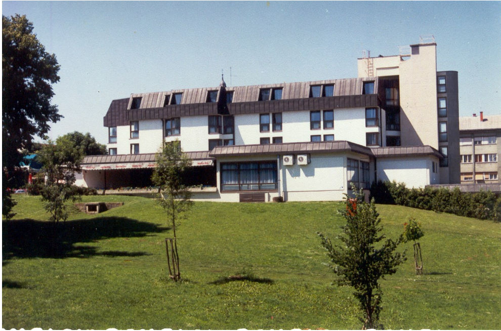
Slika 153. Istočno pročelje hotela
