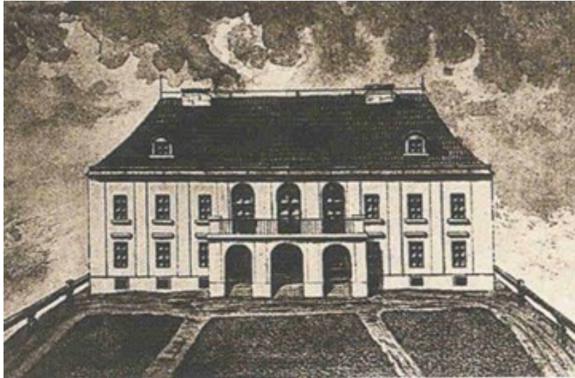
Slika 15. Dvorac obitelji Pejačević prije pregradnje, južno (glavno) pročelje
