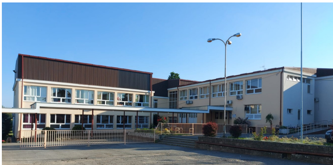
Slika 144. Pogled na sjeverno i istočno pročelje školske zgrade
