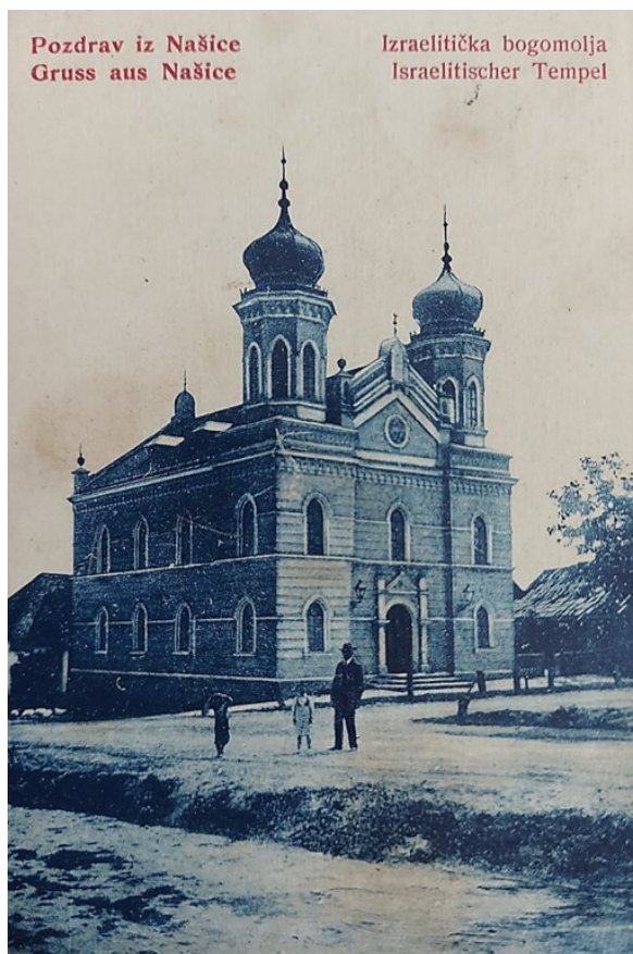
Slika 38. Pogled na glavno pročelje sinagoge
