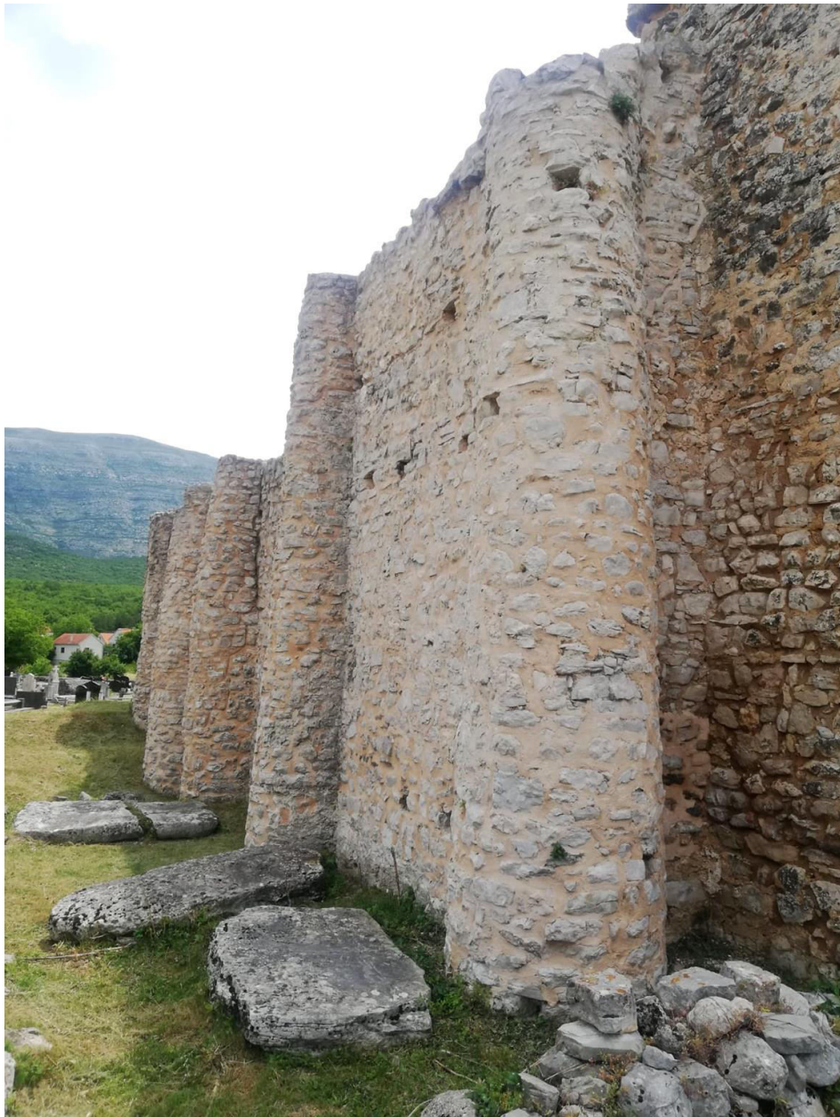
Slika 12. Obli kontrafori na sjevernom zidu crkve Sv. Spasa. Foto: Jelena Milošević
