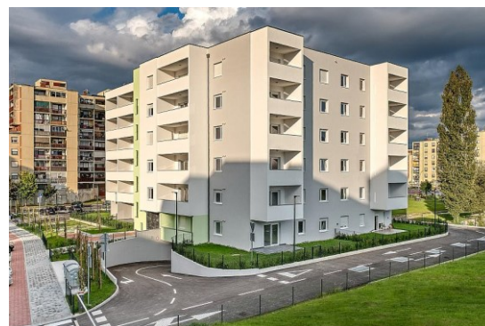
Slika 14. Stambena zgrada, gradska četvrt Grabrik, Karlovac
