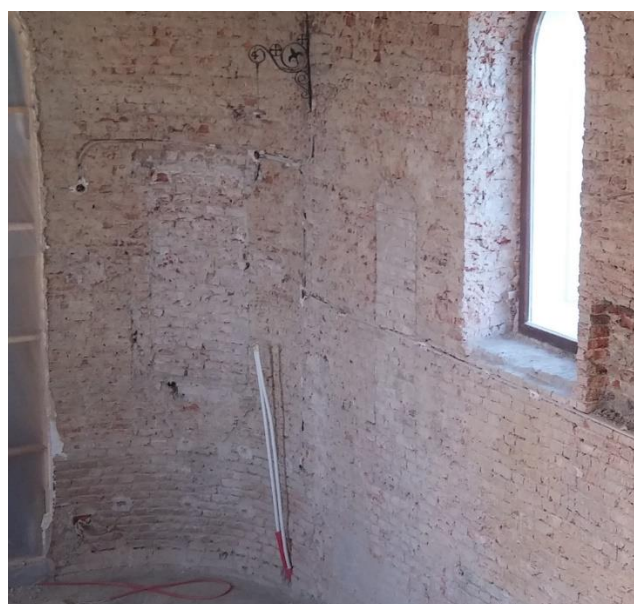
Slika 104: Zazidani ulaz u propovjedaonicu na zapadnom zidu.
