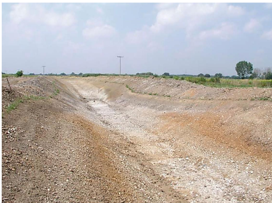
Slika 123 Strahoninec, Stara Ves, prastruja rijeke Trnave otkrivena prilikom iskopa kanala 2004. godine (Luka Bekić, Zaštitna arheologija u okolici Varaždina. Arheološka istraživanja na autocesti Zagreb – Goričan i njezinim prilaznim cestama , Zagreb 2006., str. 205)
