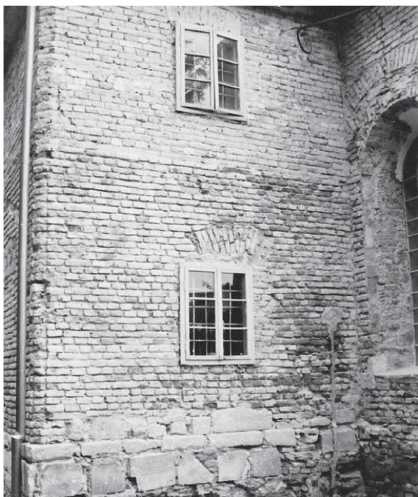
Slika 180 Vanjski zidovi sakristije snimljeni 1991. g. kad je sva žbuka bila uklonjena (Snimio Ž. Trstenjak, inv. br. 83, br. neg. 4/24, Fototeka Konzervatorskog odjela u Varaždinu; Marijana Korunek, »Župna crkva sv. Marka u međimurskoj Selnici«, u: Cris 13 (2011), str. 244); Slika 181 Djelomično otvoreni kasnogotički portal na južnom zidu lađe snimljen 1991. g. (inv. br. P/248, Fototeka Konzervatorskog odjela u Varaždinu; Marijana Korunek, »Župna crkva sv. Marka u međimurskoj Selnici«, u: Cris 13 (2011), str. 248)
