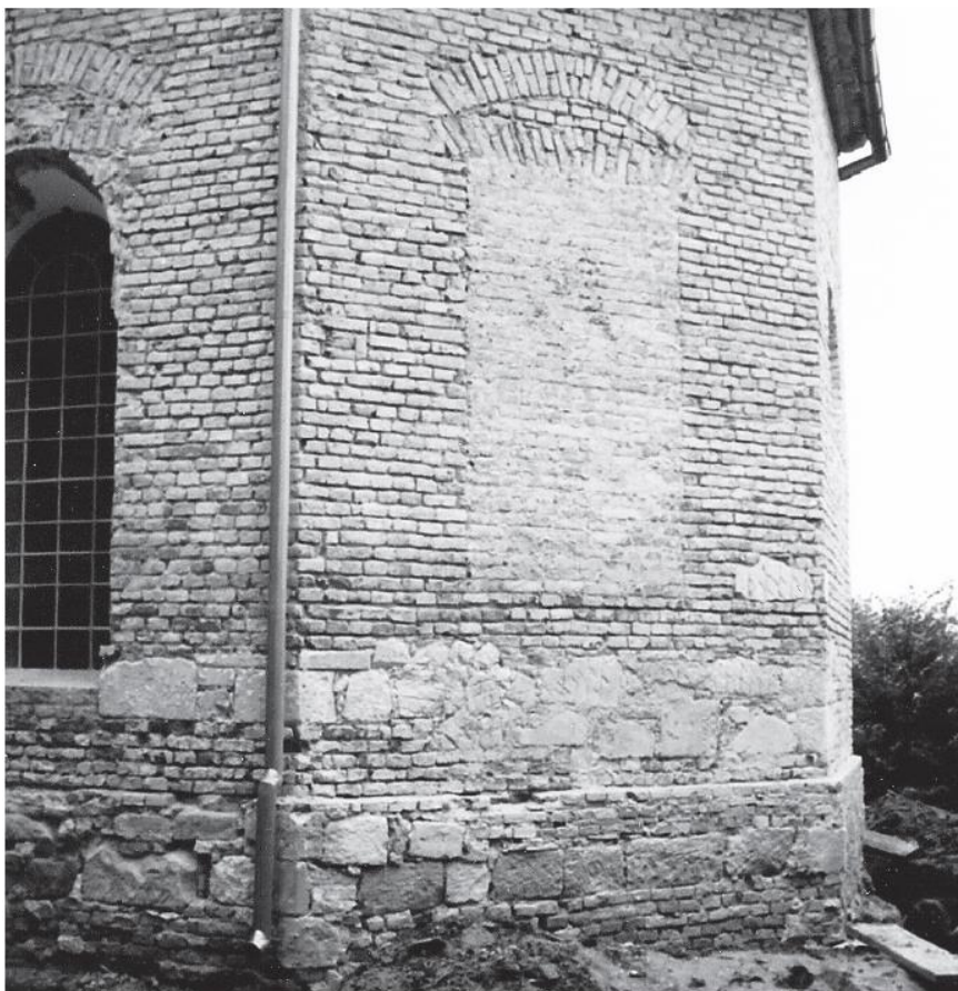
Slika 179 Vanjski zidovi svetišta snimljeni 1991. g. kad je sva žbuka bila uklonjena (Snimio Ž. Trstenjak, inv. br. 82, br. neg. 4/23, Fototeka Konzervatorskog odjela u Varaždinu; Marijana Korunek, »Župna crkva sv. Marka u međimurskoj Selnici«, u: Cris 13 (2011), str. 242)
