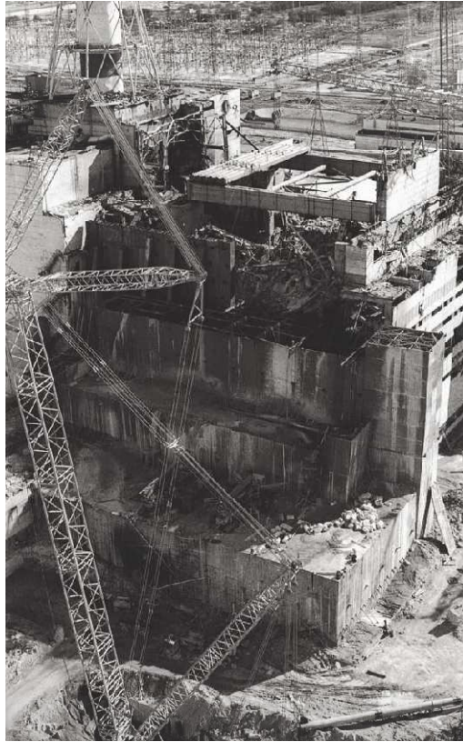
Slika 3: Eksplozija je uništila i zgradu koja se nalazila oko četvrtog reaktora [3].
