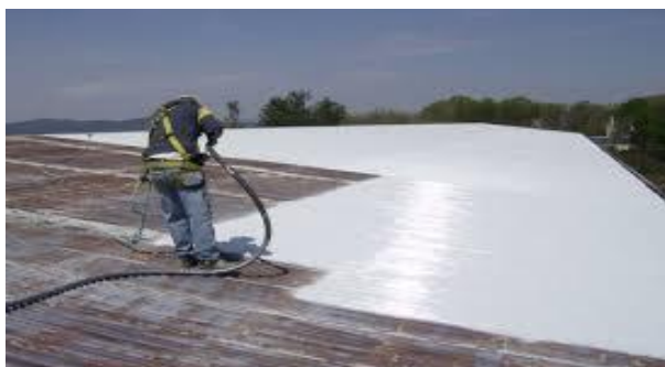
Slika 4. Primjer nanošenja organske prevlake prskanjem pomoću mlaznice [5]
