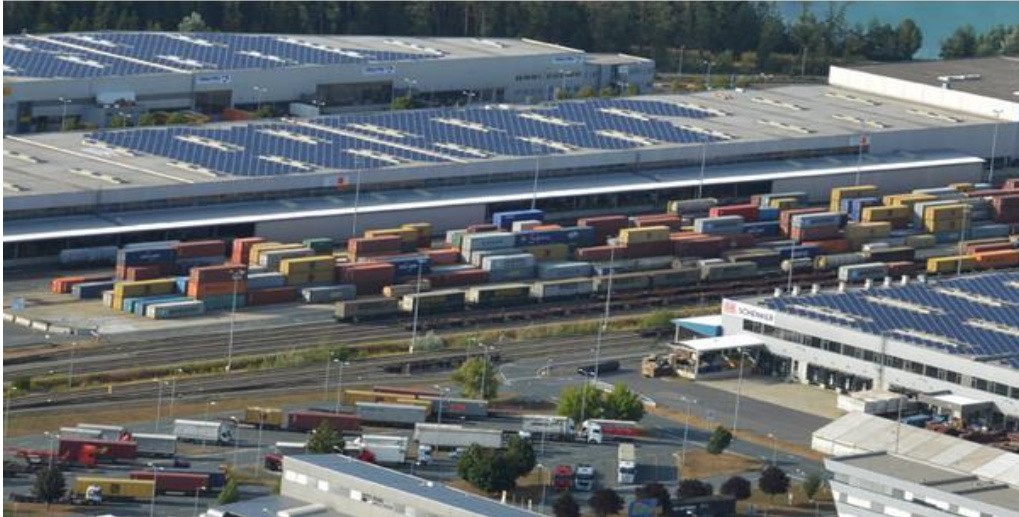
Slika 10: Solarni paneli Cargo Centra Graz
