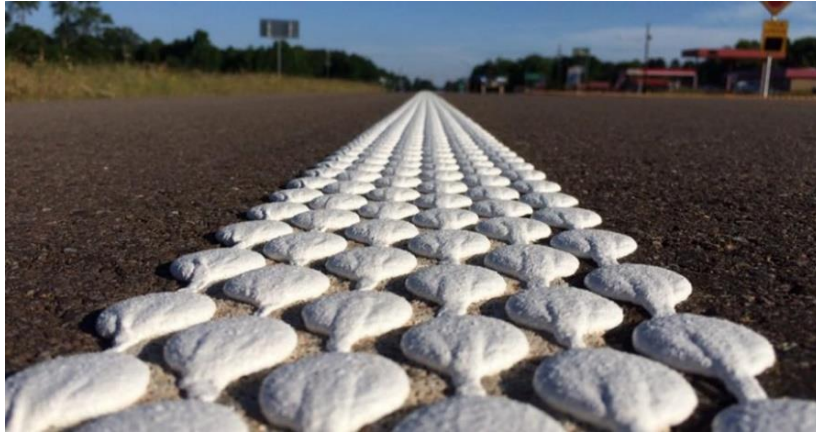
Slika 10. Primjer strukturirane oznake izrađene od termoplastike
