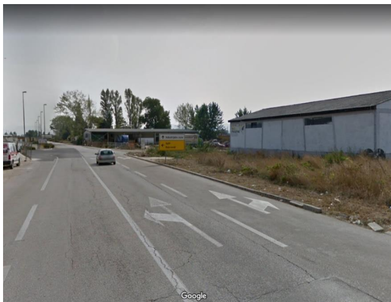
Slika 24. Prikaz lokacije 4 - zapadni prilaz Izvor: [7]
