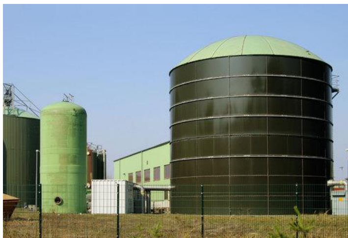
Slika 66. Primjer tanka za skladištenje tekuće rasute biomase
