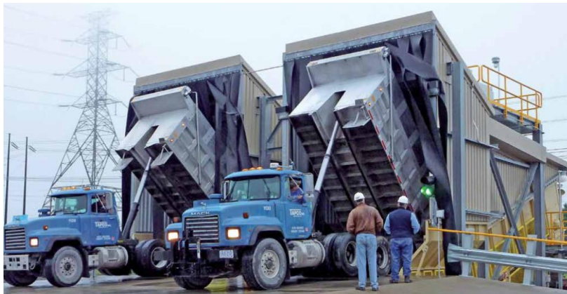
Slika 26. Iskrcaj biomase iz kamiona sa poluprikolicom
