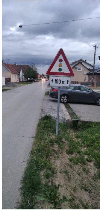
Slika 41. Krivo postavljena dopunska ploča
