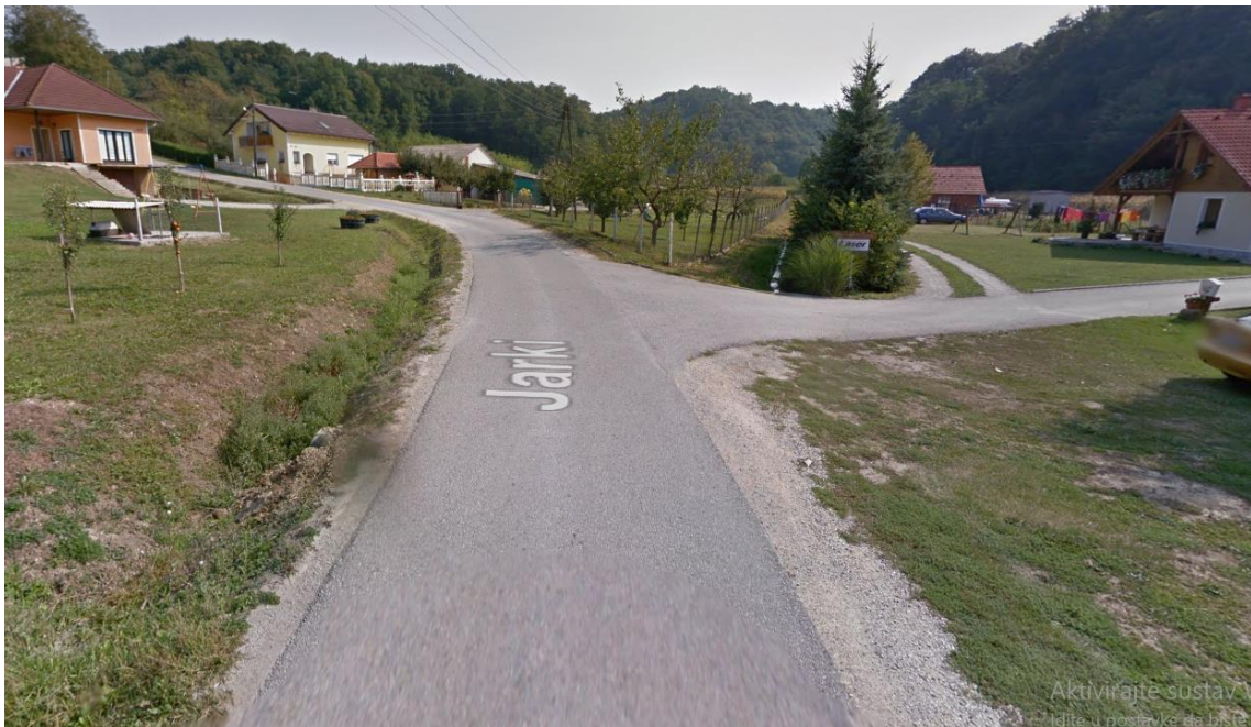
Slika 24. Nedostatna prometna signalizacija i širina kolnika na županijskoj cesti Ž2027
