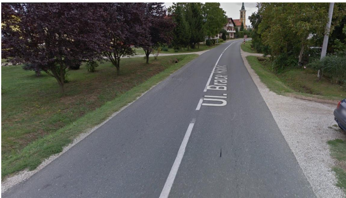
Slika 26. Nedostatak pješačke staze na županijskoj cesti Ž2071
