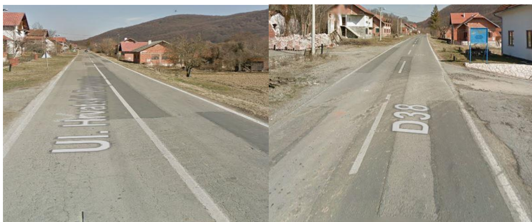
Slika 24. OM Pakrac – prije sanacije
