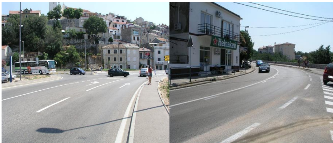
Slika 12. OM Novi Vinodolski – prije sanacije
