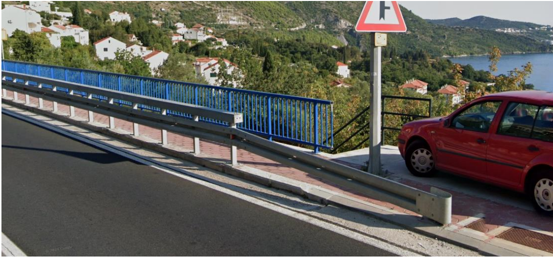
Slika 14. Ispravno izveden završetak/početak čelične zaštitne ograde - Primjer 1 Izvor:[23]
