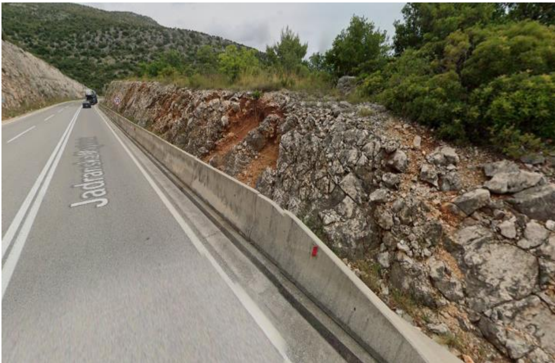
Slika 20. Ispravno izveden završetak/početak betonske zaštitne ograde - Primjer 1 Izvor:[23]
