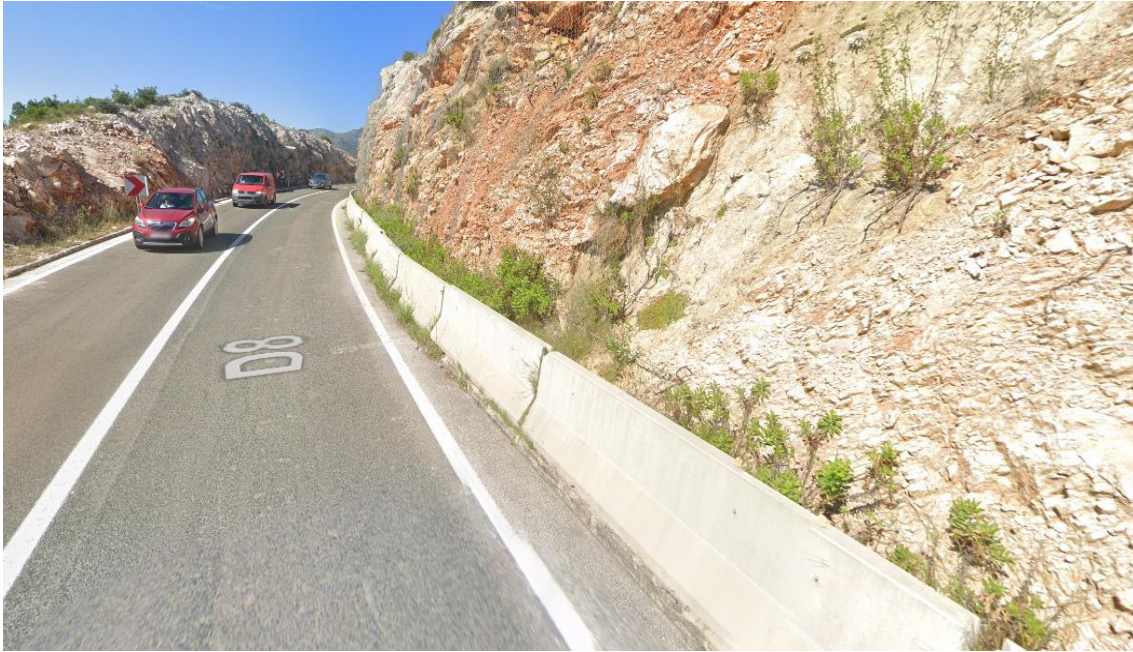
Slika 21. Ispravno izvedena betonska zaštitna ograda - Primjer 2 Izvor:[23]
