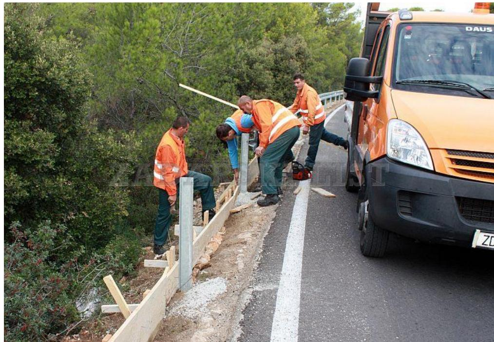
**Slika 3.** Prikaz popravka oštećene zaštitne ograde, [22]
