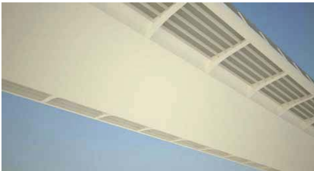
Slika 9. Podgled mosta – uzdužna rebra na konzoli
