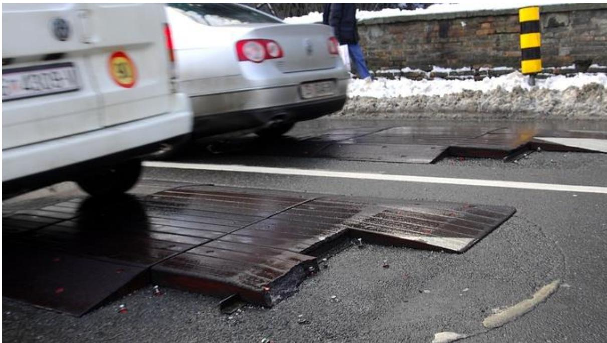
**Slika 11.** Primjer oštećenog uspornika
