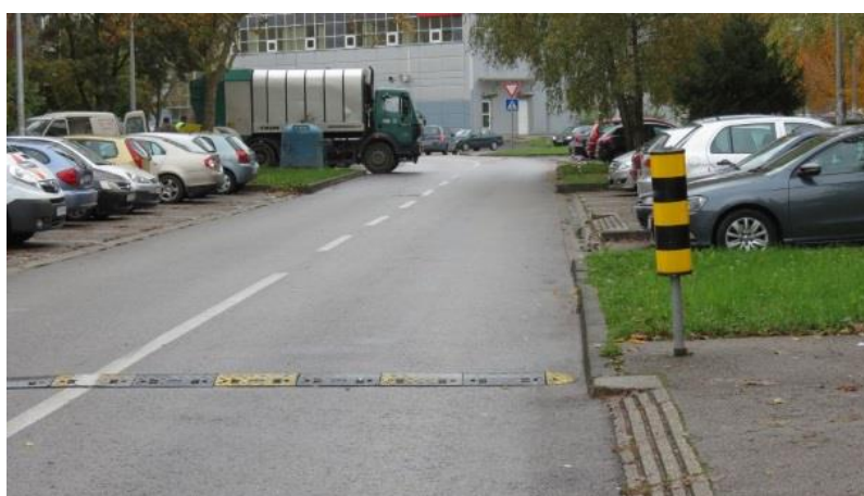
Slika 57. Primjer lošeg uspornika Izvor:[19]
