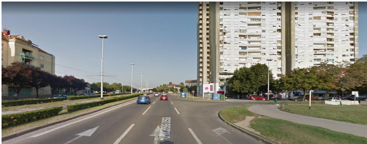
Slika 37. Horvaćanskacesta- neoznačen pješački i biciklistički prijelaz
