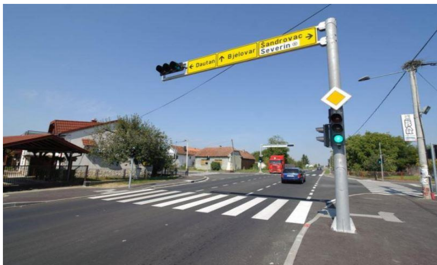
Slika 19. OM Severin – poslije sanacije
