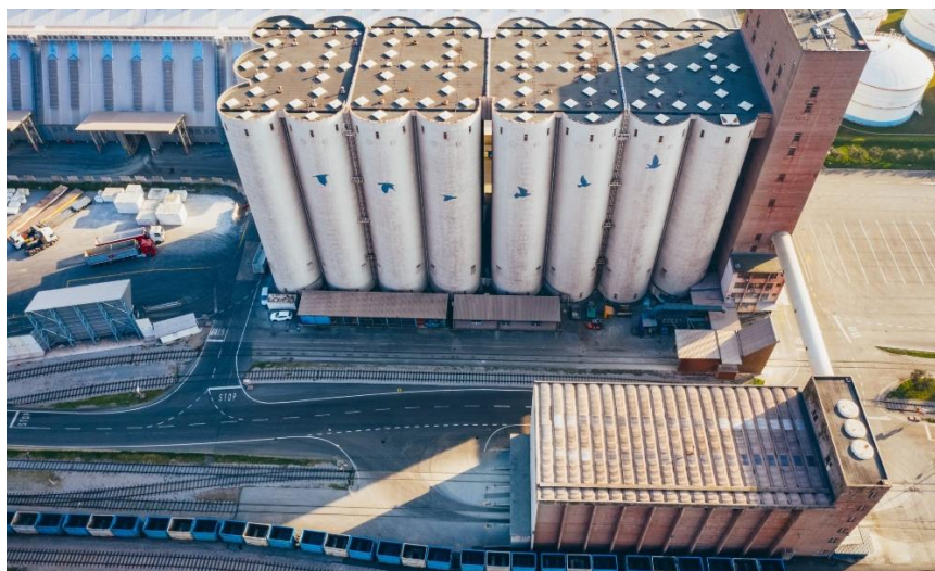
Slika 19. Terminal silosa u luci Kopar, [24]
