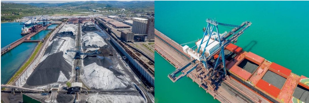
Slika 21. Terminal za ugljen i željeznu rudu u luci Kopar
