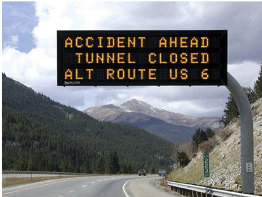
Slika 10. Obavijest o promjeni rute pomoću promjenjivog prometnog znaka
