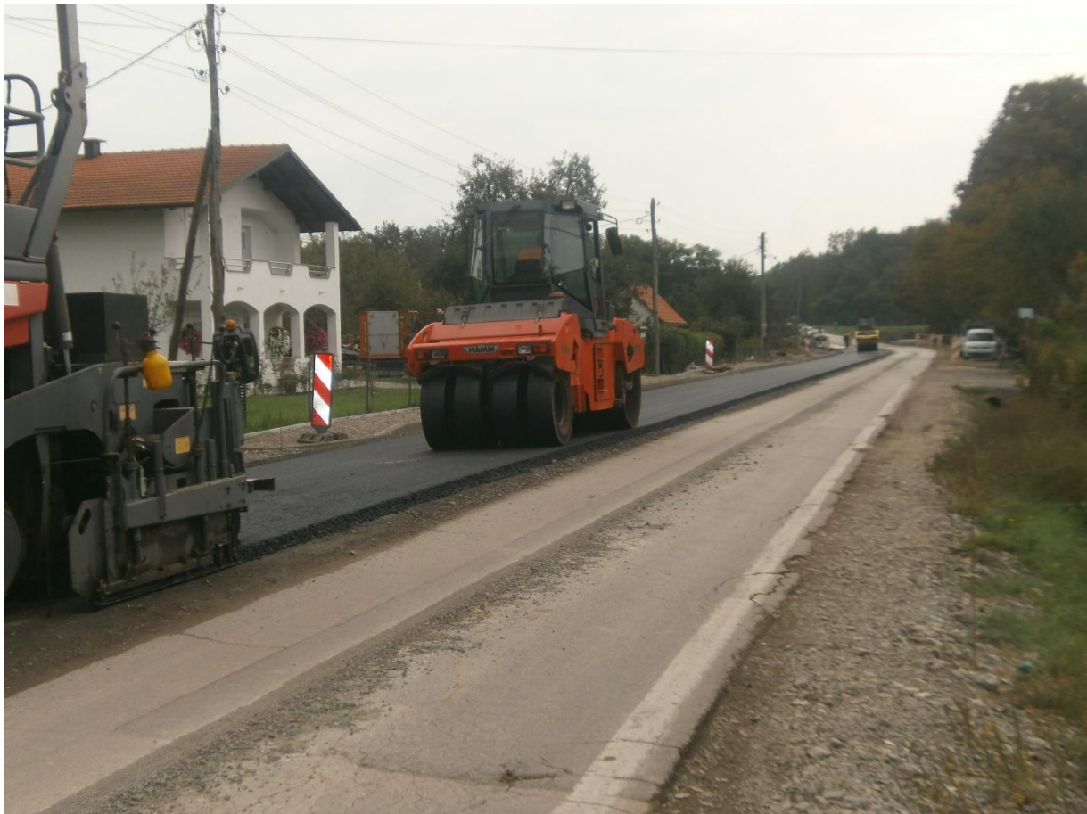
Slika 23. Postavljanje habajućeg sloja asfalta
