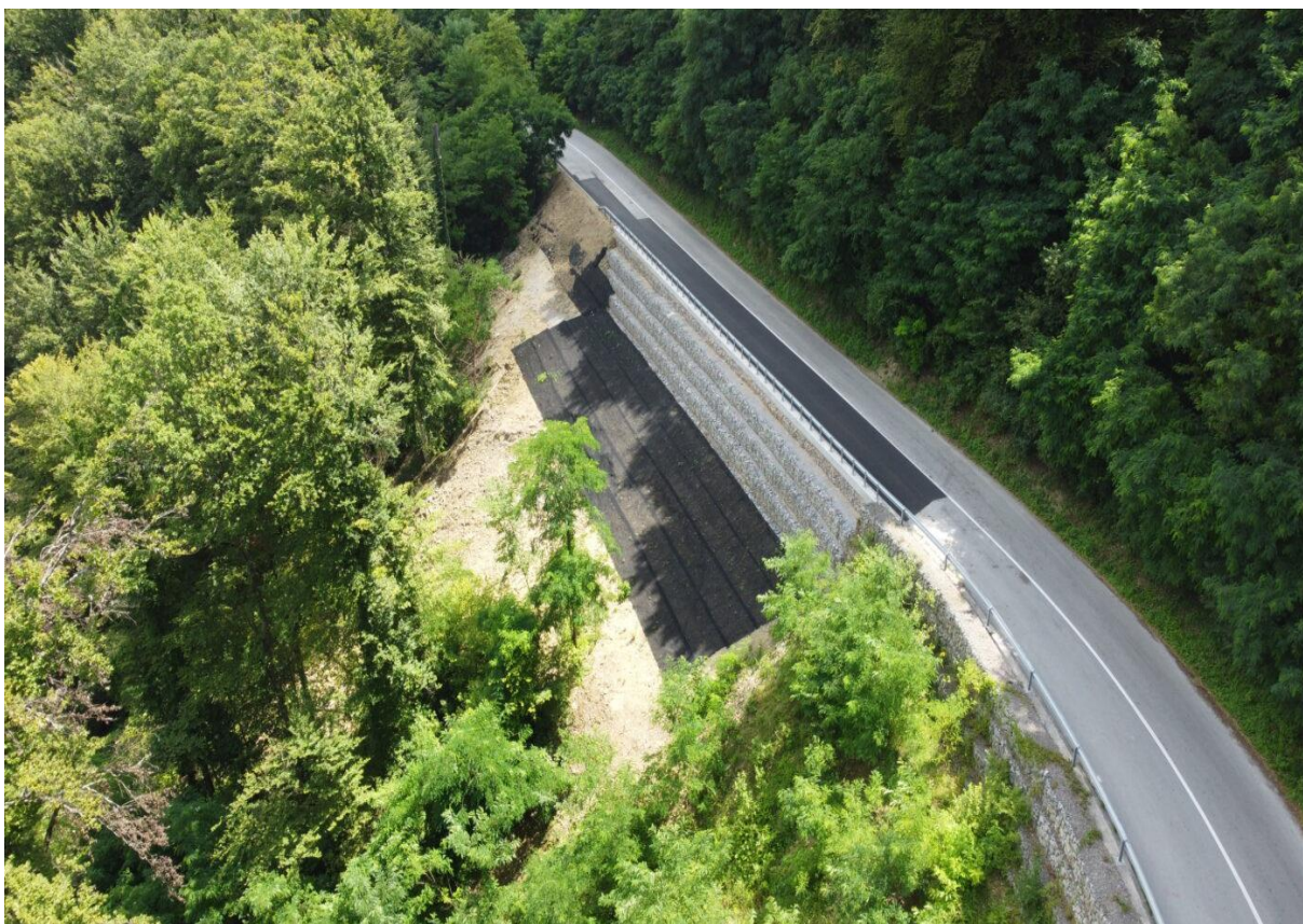
Slika 25. Sanacija klizišta na dionici Slunj - Maljevac
