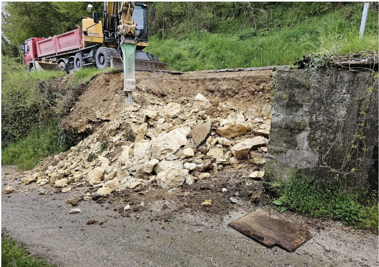
Slika 26. Sanacija ceste kod Ozlja
