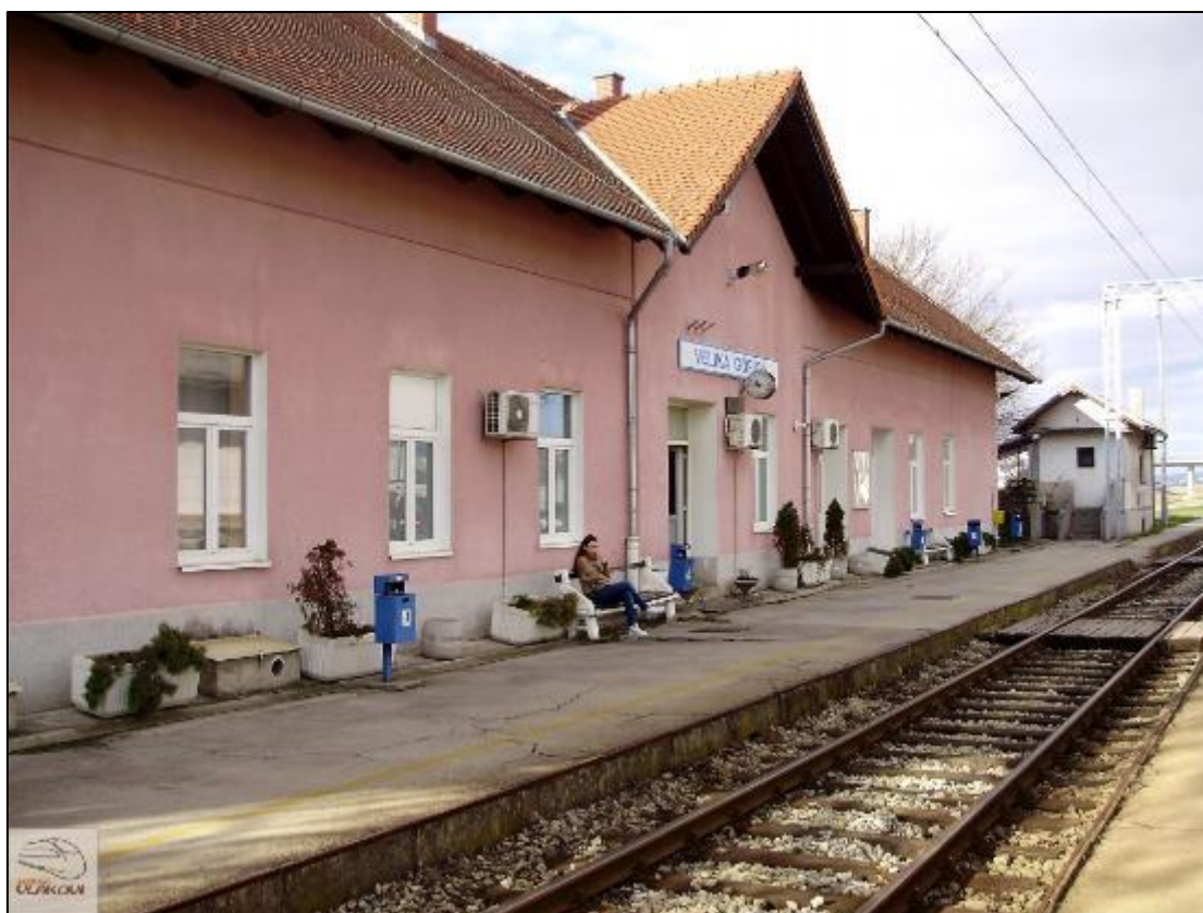
Slika 5.7. Željeznički kolodvor Velika Gorica, [36]
