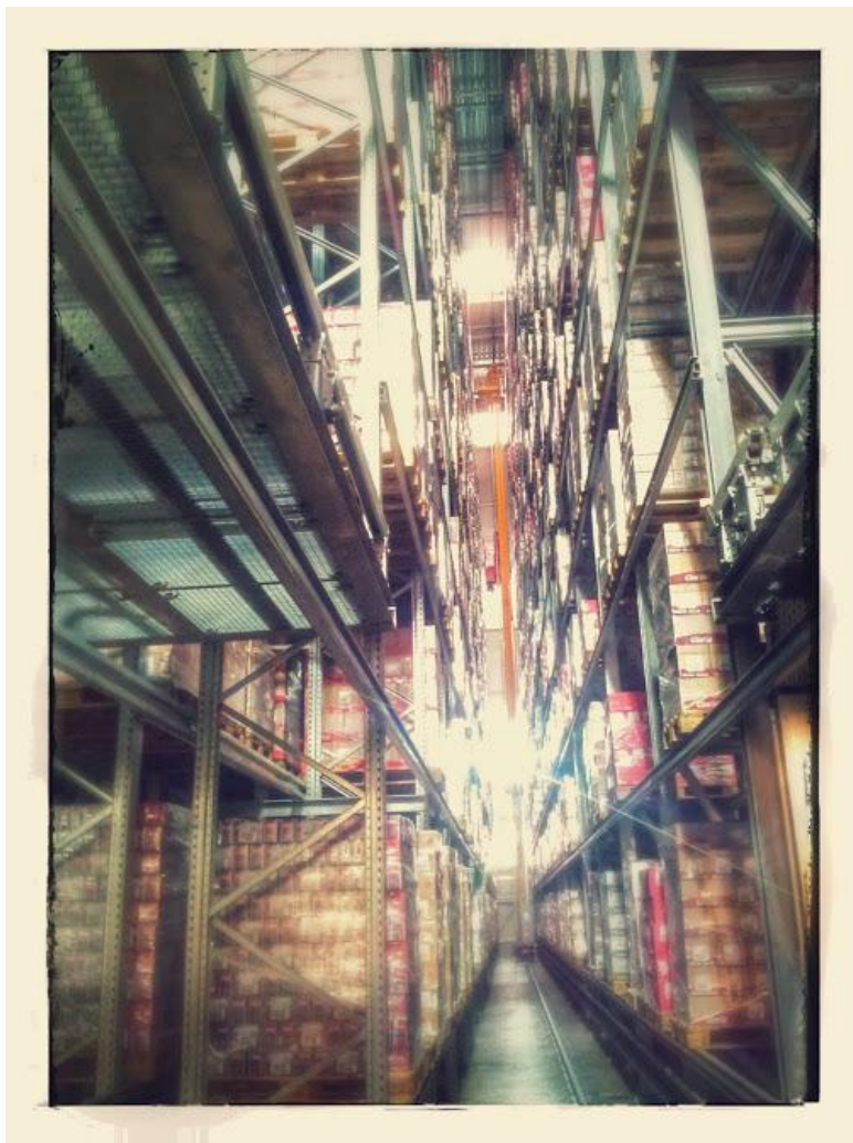
Slika 41. S/R dizalica u prolazu
