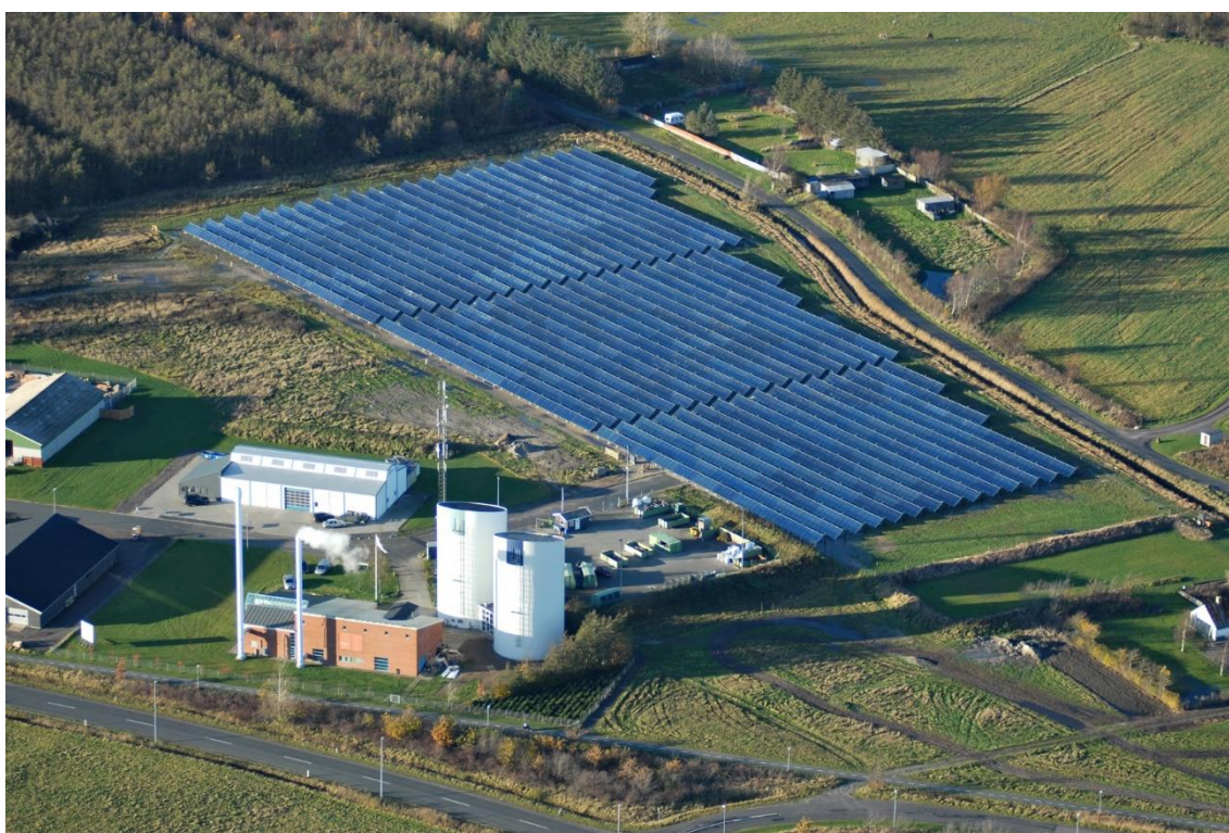
Slika 5 Postrojenje za proizvodnju toplinske energije u Strandbyu [32]
