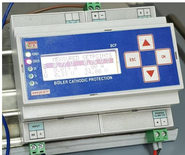
**Slika 32. Detaljan prikaz upravljačke jedinice s vidljivim parametrima katodne zaštite**
