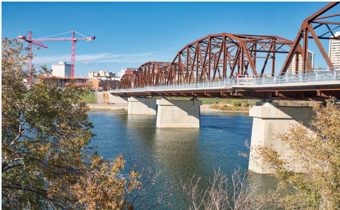
Slika 9. Most od Corten čelika [23]
