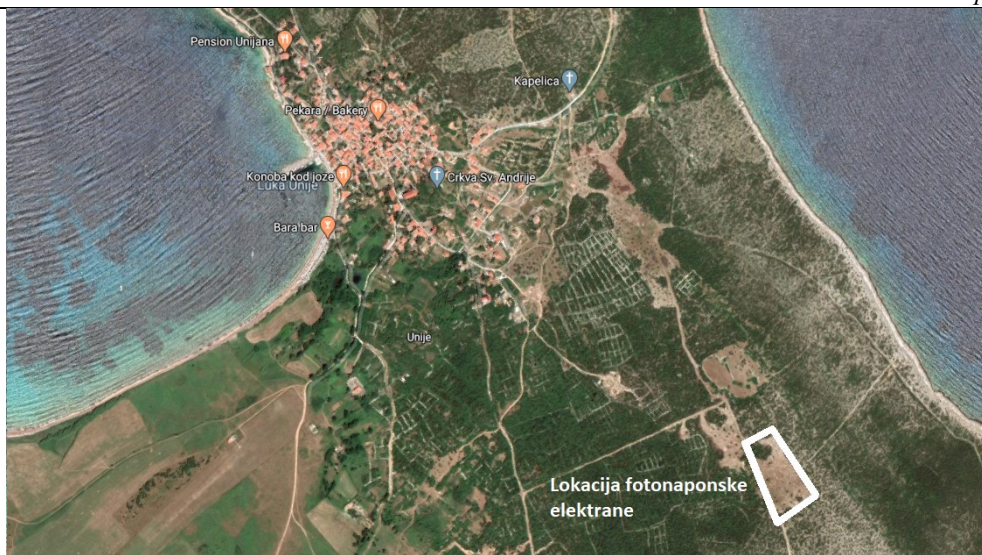
Slika 14. Prikaz lokacije fotonaponske elektrane [15]
