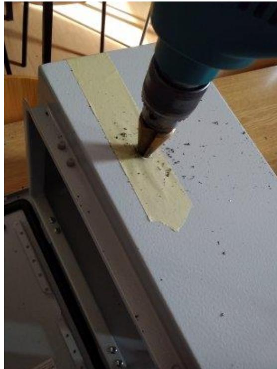
**Slika 30. Bušenje razvodnog ormara**
