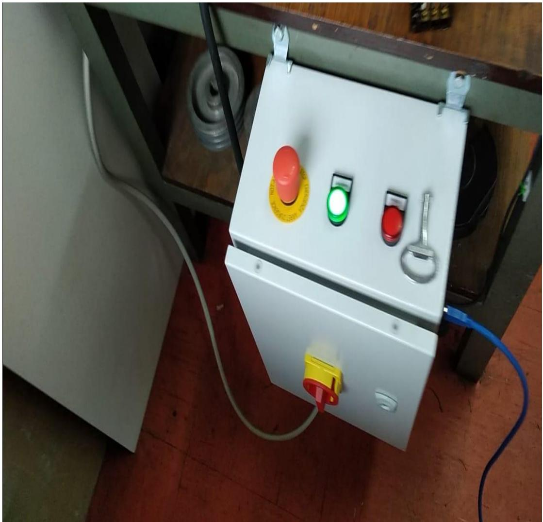
**Slika 36.** Montiran razvodni ormar
