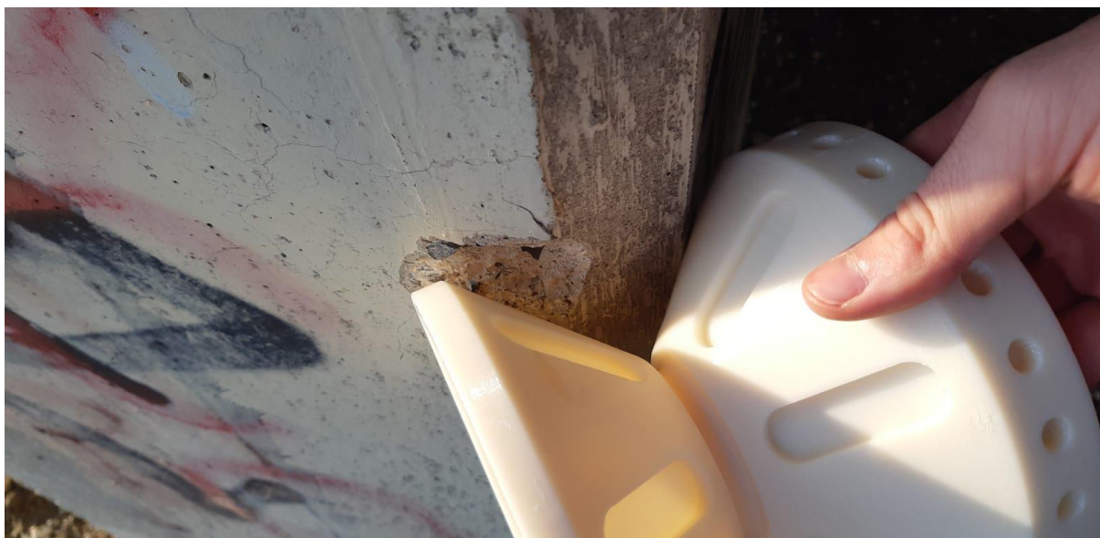
Slika 5.13. Prikaz pogonskog kotača i stupa na Jadranskom mostu
