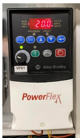
Slika 33. AB PowerFlex VF pretvarač
