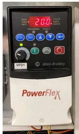
Slika 33. AB PowerFlex VF pretvarač
