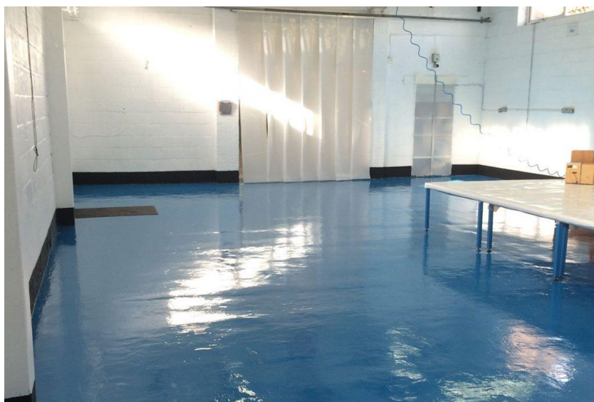
Slika 15. Pod od tekućeg epoksidnog premaza [25]
